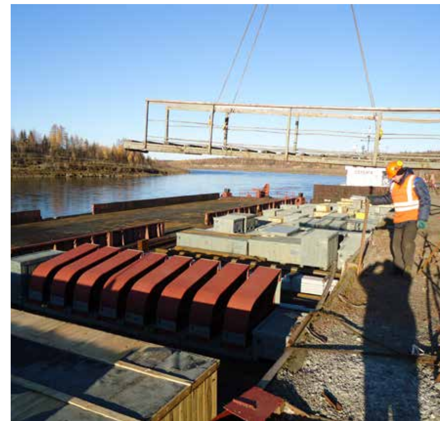
Выгрузка оборудования с барж на Причале №5.
