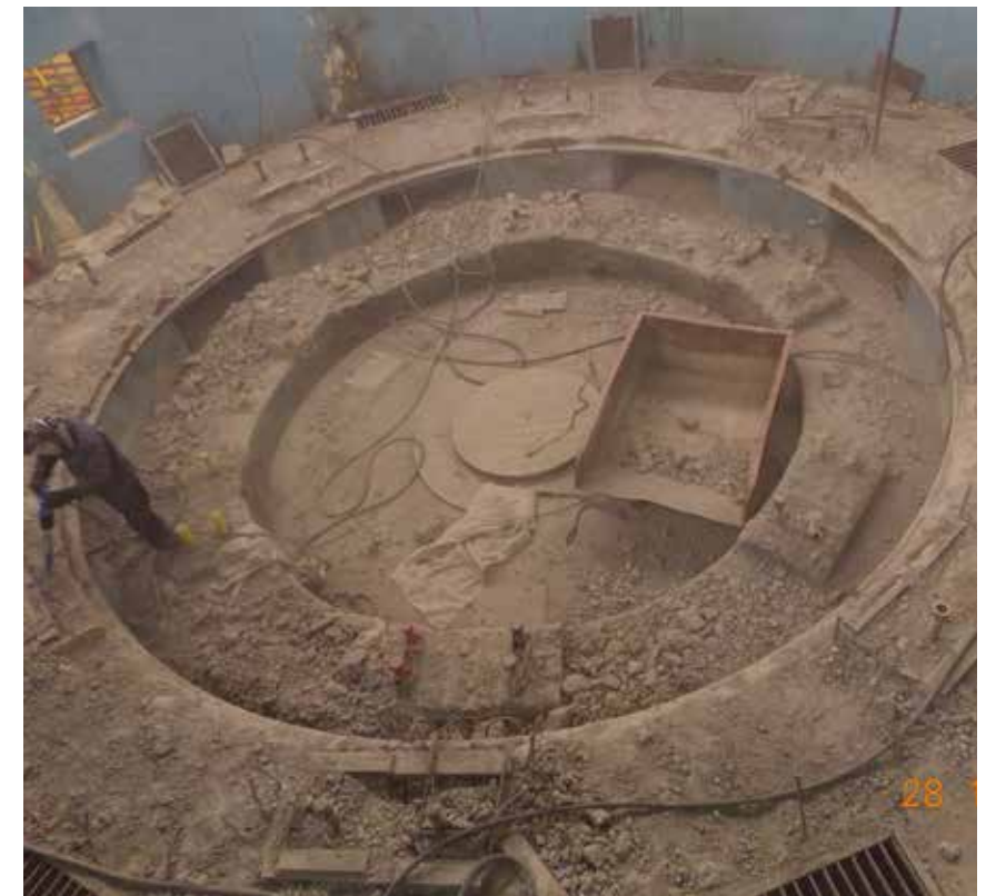
Демонтаж фундаментов гидрогенератора
