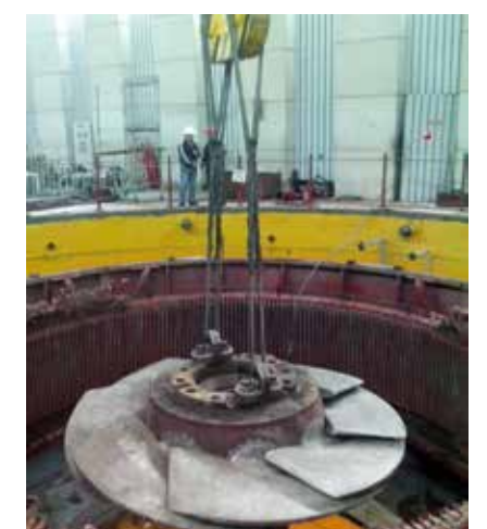
Демонтаж рабочего колеса гидротурбины
