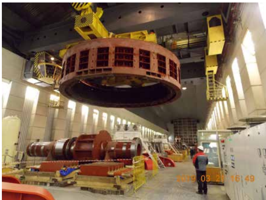
Перенос корпуса статора гидрогенератора
